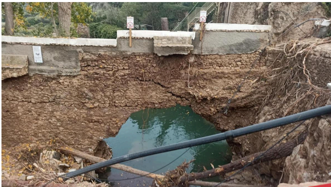
Vista de uno de los puentes de entrada al casco histórico de Letur. / R. B.
