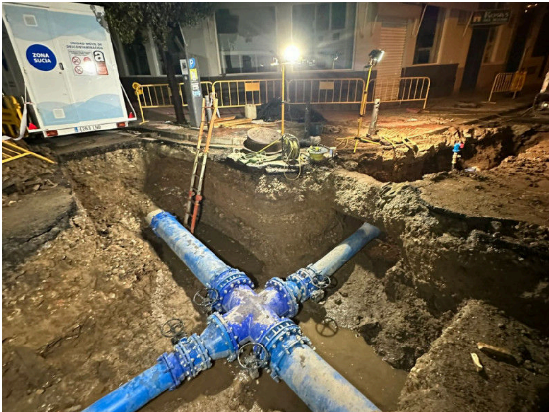
Nueva tubería en la calle Vespasiano
