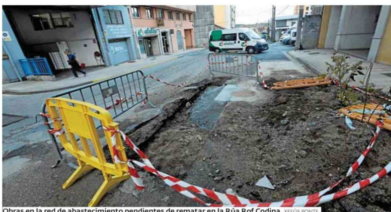
Obras en la red de abastecimiento pendientes de rematar en la Rúa Rof Codina. XESÚS PONTE
